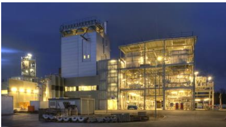
Figure 6 : L'unité de gazéification à haute pression bioliq II à Karlsruhe. Source : KIT ©
